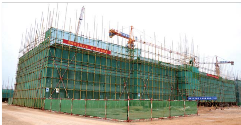
►海曲新城高中学生公寓楼主体在建。(资料图)
