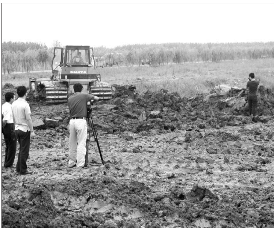
采煤塌陷地整治施工现场(资料图)
