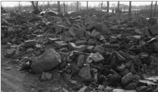
碎石板、废弃板材等堆积在一起。 本报见习记者 张童 摄
