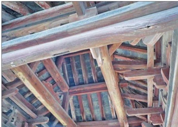
钟楼内部木结构。
