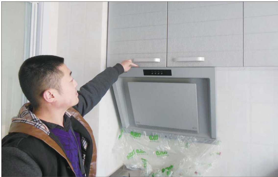
油烟机和壁橱间没有间隙，赵先生觉得以后维修会很困难。本报记者王永军 摄
