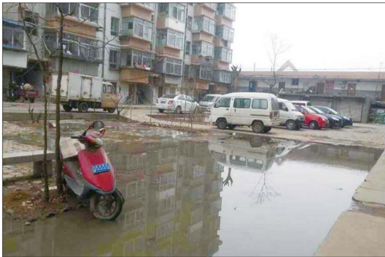
楚毓社区24号楼前化粪池的污水溢出来,最深处有十多厘米。本报实习生王姝晗 摄
