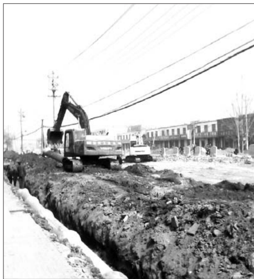
车站南路施工现场。本报记者 公素云 摄
