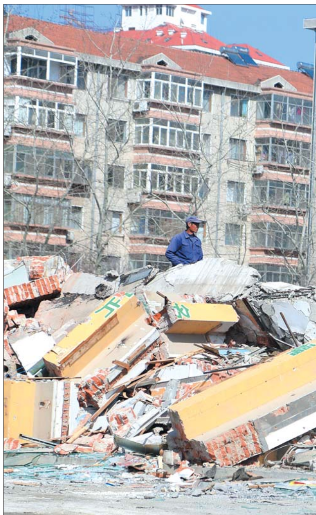
烟台大学北门附近,一栋老楼正在拆迁,产生了不少建筑垃圾。 本报记者 韩逸 摄
