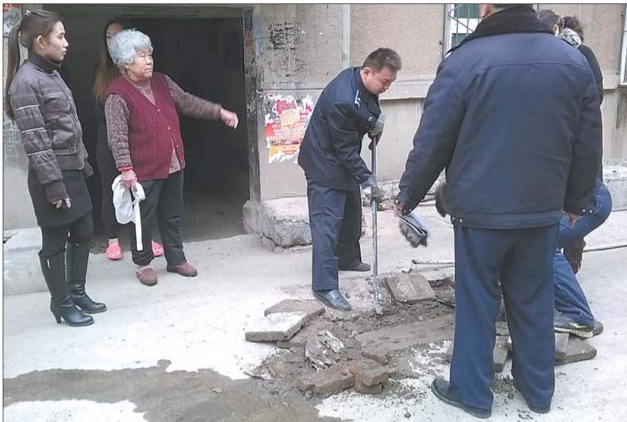
城肥二处工作人员在清理化粪池。
