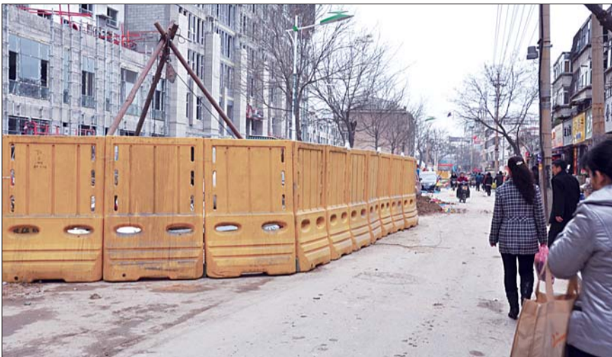
刘庄路雨污分流工程施工现场。本报记者 公素云 摄
