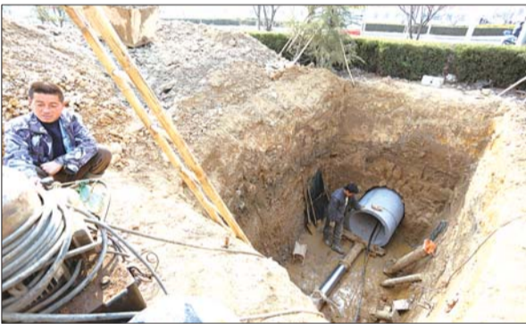
施工人员敷设供水管道。 本报通讯员 陈磊 摄
