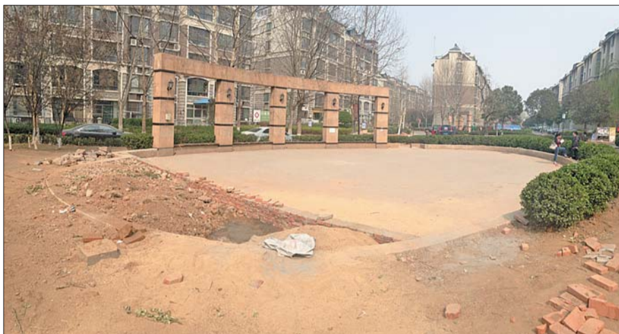
广场西侧已经圈起并垒起了砖墙。 实习生 邵裕茗 摄
