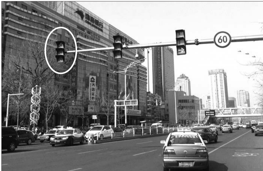
南大街与海港路路口设置了可变信号灯,在东口靠中央的左拐直行可变车道行驶的车辆,可根据可变指示箭头,在不同时间段左拐或者直行。(圈中即为可变信号灯) 通讯员供图
