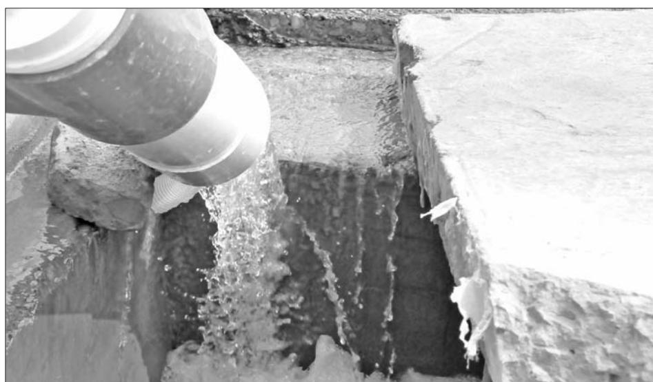
在西关街棚户区改造回迁安置工地,抽出的地下水直接排入下水道。 本报记者 王传胜 摄
