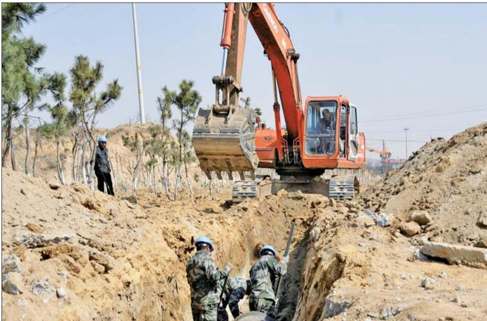
为满足日益增长的银滩业主用水需求,今年银滩在滨海一体规划中,启动了总长3.8千米的供水主管道建设工程。该工程预计4月中旬完工,完工后,将与之前东部铺设的主管道进行对接,成为银滩供水的第二条主管道。
