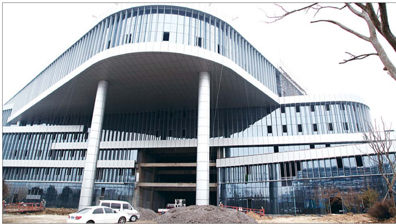
建设中的创意大厦。本报记者 张晓科 摄
