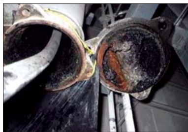
腐蚀老化的管道
