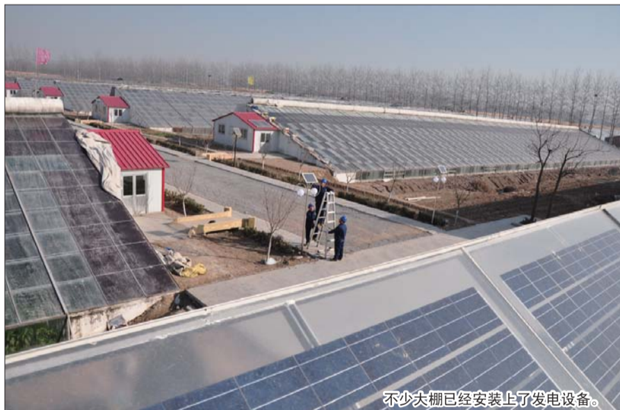
工作人员正在安装发电设备。
