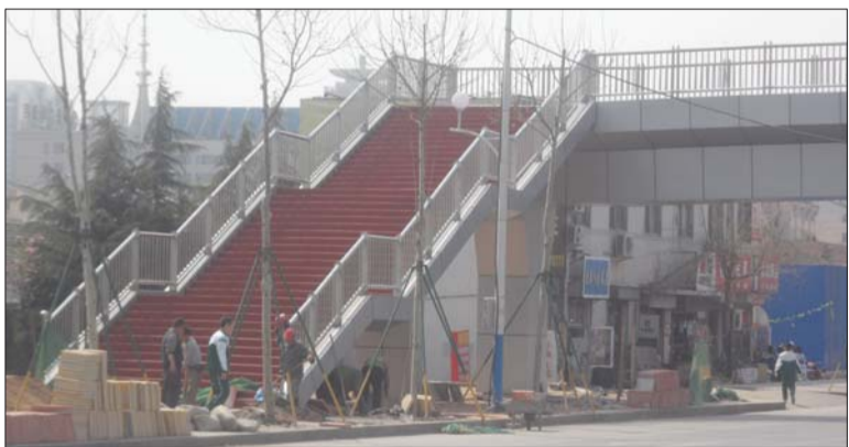
擂鼓石大街过街天桥铺上塑胶。本报记者 侯峰 摄
