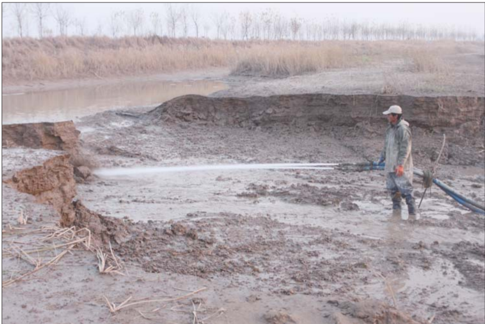
小开河沉砂池治理工程
