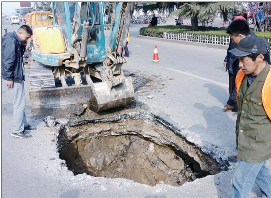
市政工作人员正在施工。 本报记者 路帅 摄
