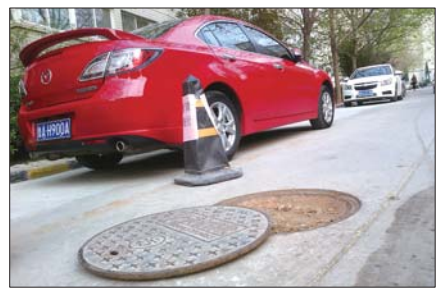
经常被车辆轧翻的问题井盖边设置了绕行路标 实习生 高凤林 摄
