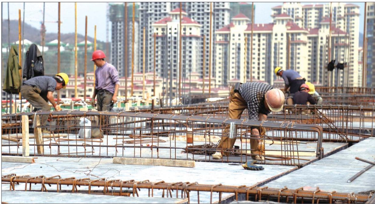
目前,企业服务中心将盖第十层,工人们正在第九层楼顶加固钢筋。 本报记者 韩逸 摄
