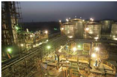
煤化工产业初具雏形
