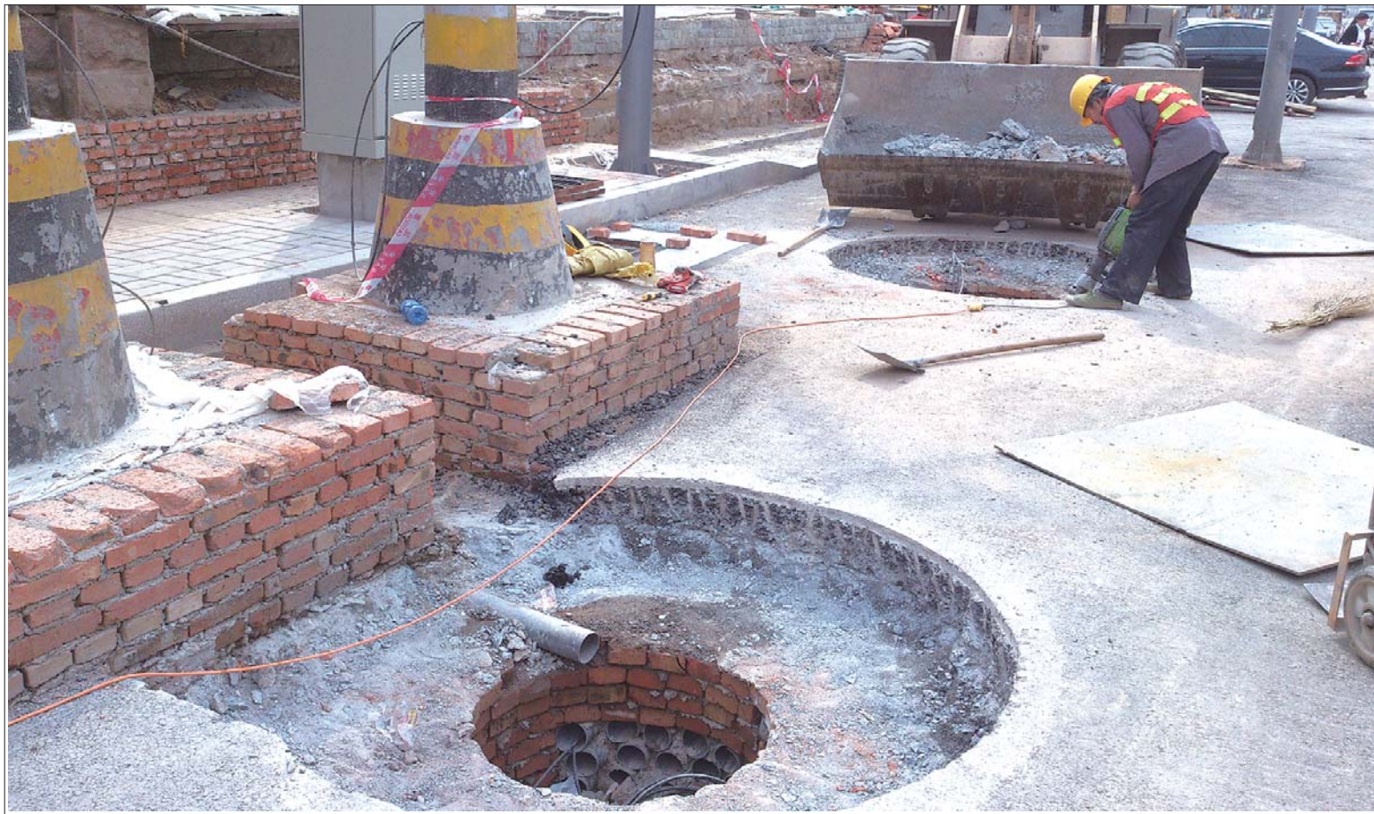
和平路正在进行井盖更换工作,省城将逐渐消灭“马路杀手”。见习记者 王皇 摄
