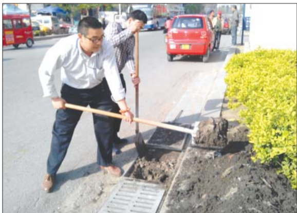
两位商户职工正在清理下水道。本报见习记者 闫克杭 摄
