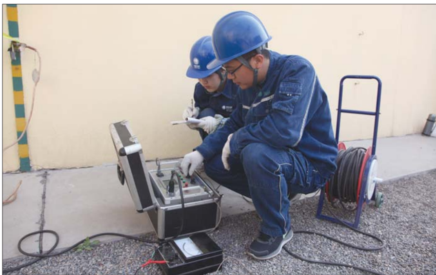
供电公司工作人员检查线路。本报记者 王世腾 摄
