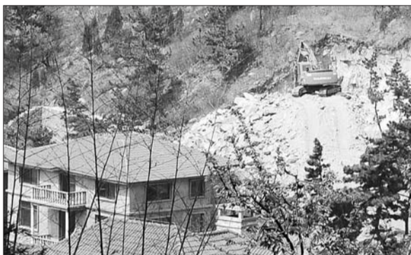
山坡上正在作业的挖掘机。
