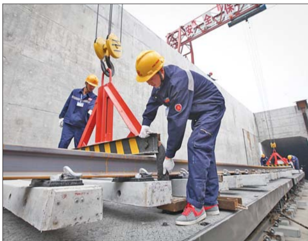
钢轨吊运至隧道口。 本报记者 杨广帅 摄
