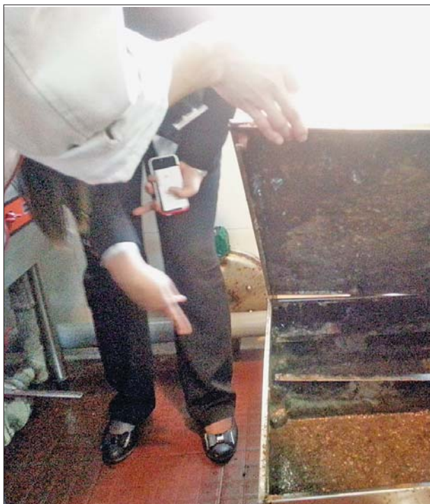
鼎好家常菜馆的厨房里加挂了油水分离器。
