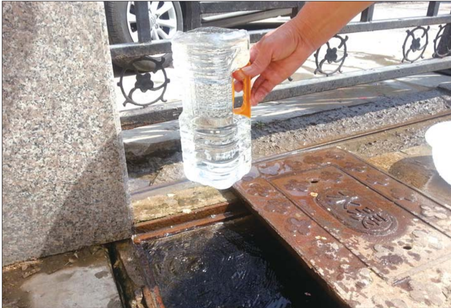
从地下自来水管破裂漏水聚集的水坑中,可盛出清澈的自来水。 本报见习记者 任丽媛 摄
