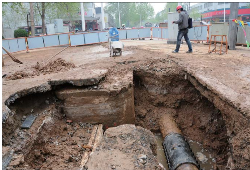
10日8时左右,张店潘南西路供水管道破裂点已被修好。 本报记者 姜文洁 摄
