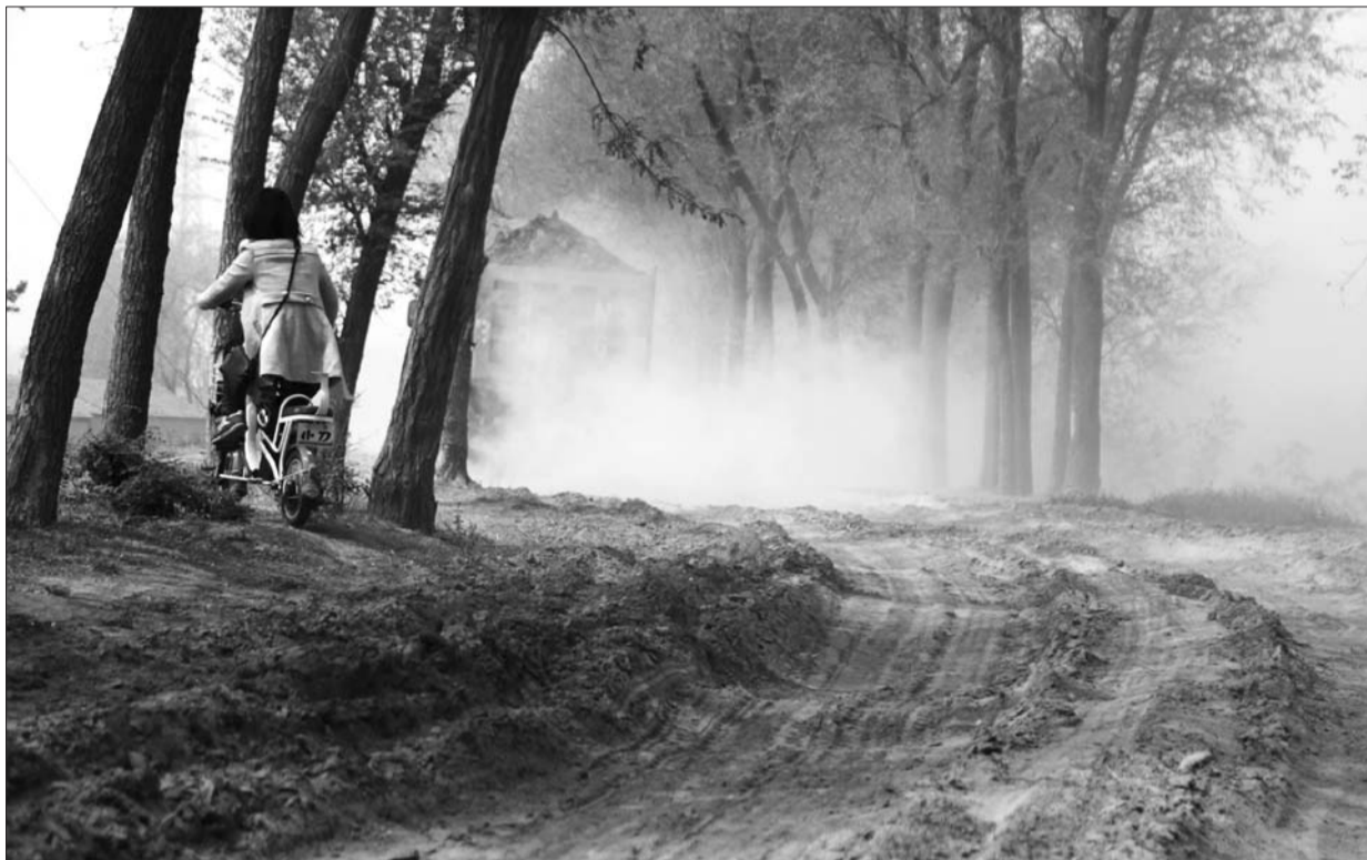
13日,北厂段运河大堤上有多辆渣土车来往通行,土路大堤被碾轧下陷。 本报记者 王小会 摄
