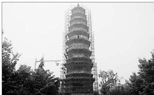
龙泉塔周身搭建了支架,目前正在进行3D测绘。 本报记者 甘倩茹 摄
