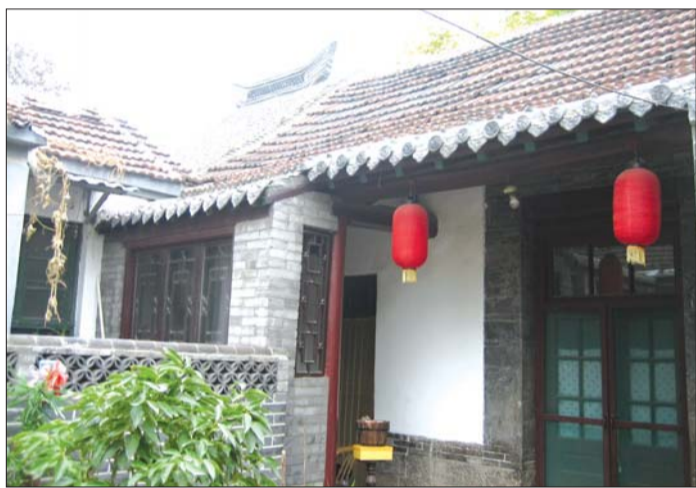
曲水亭街15号院内的蝎子尾屋脊。栾磊 摄
