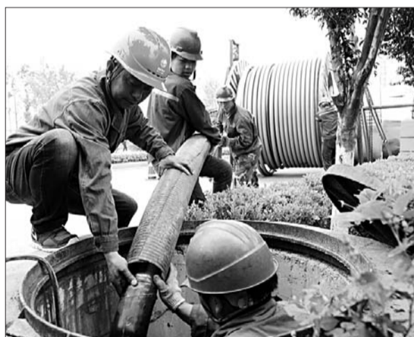
工作人员正在往地下隧道牵引电缆。本报记者 公素云 摄
