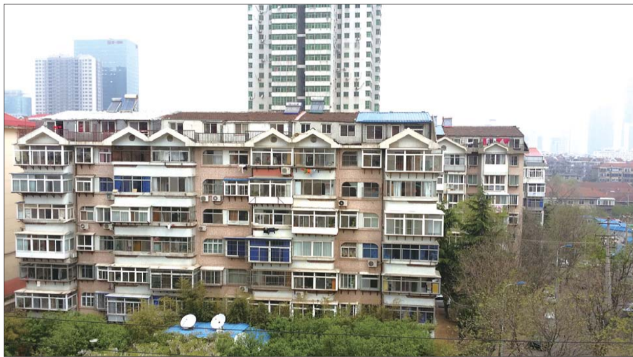
奇山小区内一居民楼在原本6层的基础上又加盖了一层。 本报记者 蒋大伟 摄
