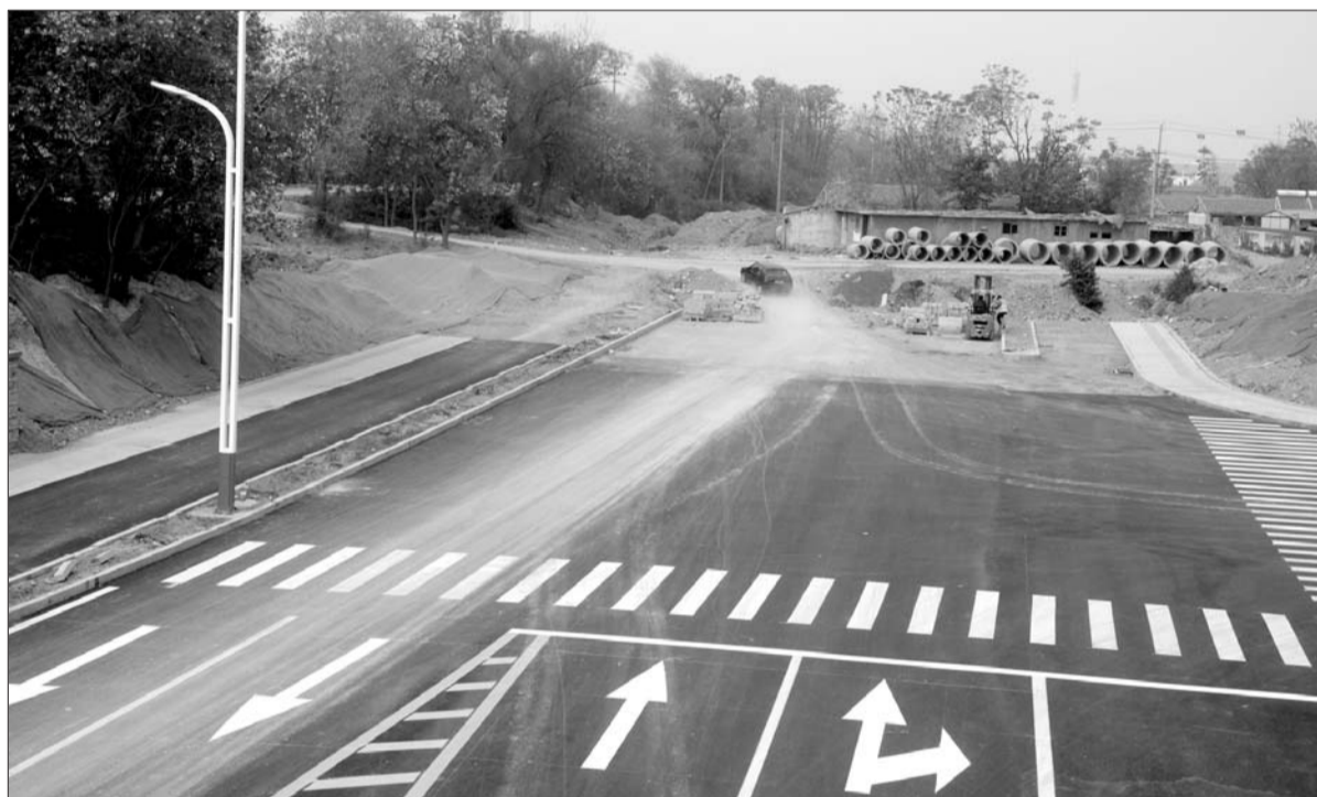
半截路 岔河东大道大部分道路已近修建完工,但在东方红路与三八路之间的十余户民房还未动工拆迁,岔河东大道被拦腰截断。4月21日,车辆从岔河东大道中断处驶向施工便道。 本报记者 马志勇 摄
