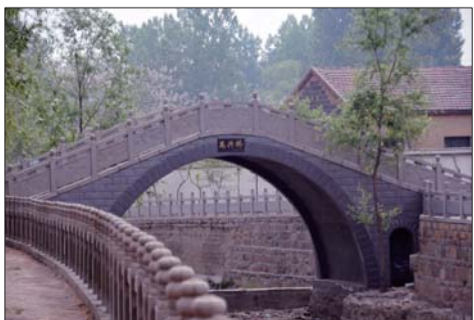
▲万安溪位于万家村南侧,溪上建有一座万兴桥。
