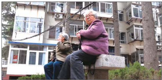
忠义街一小区里,多股电缆捆在一起,距地面仅两米多高。见习记者 吕奇 摄
