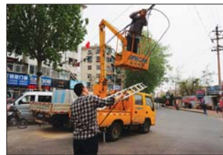
工作人员在现场处理脱落的缆线。本报记者 于明红 摄
