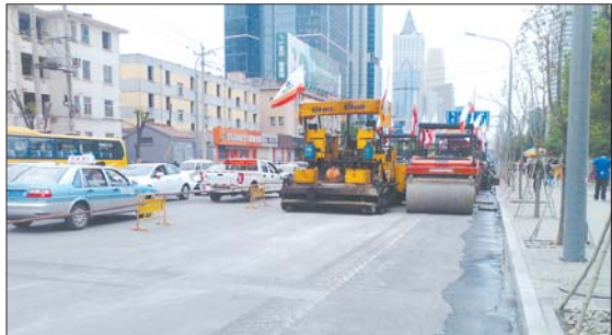
25日,和平路双向大部分车道已经被隔离栏杆隔开,为沥青铺设做最后准备。
