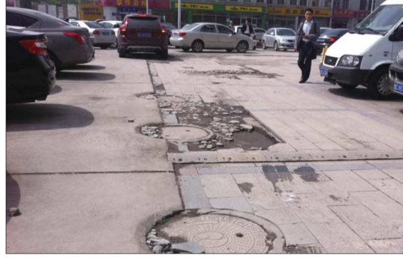
28日10点左右,记者来到东方之珠大楼前,只见围绕楼前的路大概300米长,8米宽。水泥路面上每隔几米就有一个坑,一般直径在50厘米左右,大的直径可达一米多;多处大理石的路面也被轧坏。来往的车辆在坑坑洼洼的路上左右摇晃着向前行驶。
