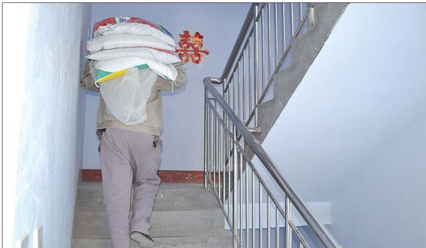
装修工人往13楼扛材料。本报记者 王伟强 摄
