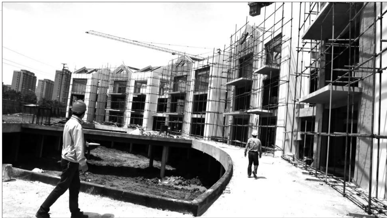
印象吟龙湾一期工程主体建设已完工。本报记者 张晓科 摄
