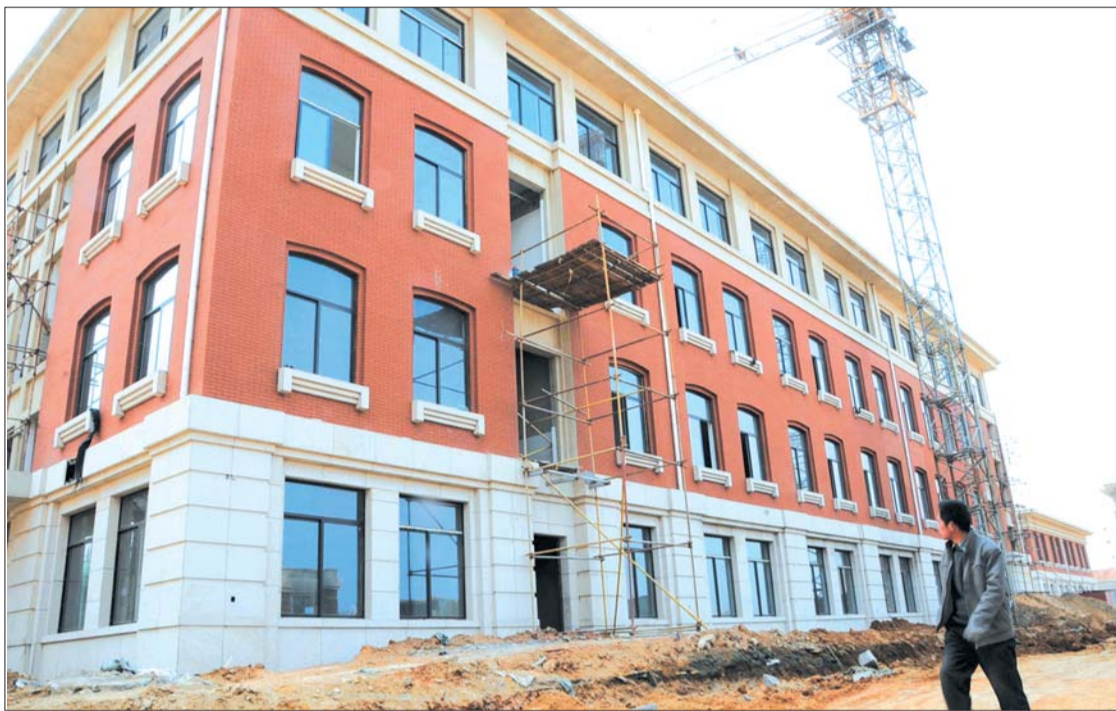
正在建设的二中新校区很有范儿。本报记者李泊静摄
