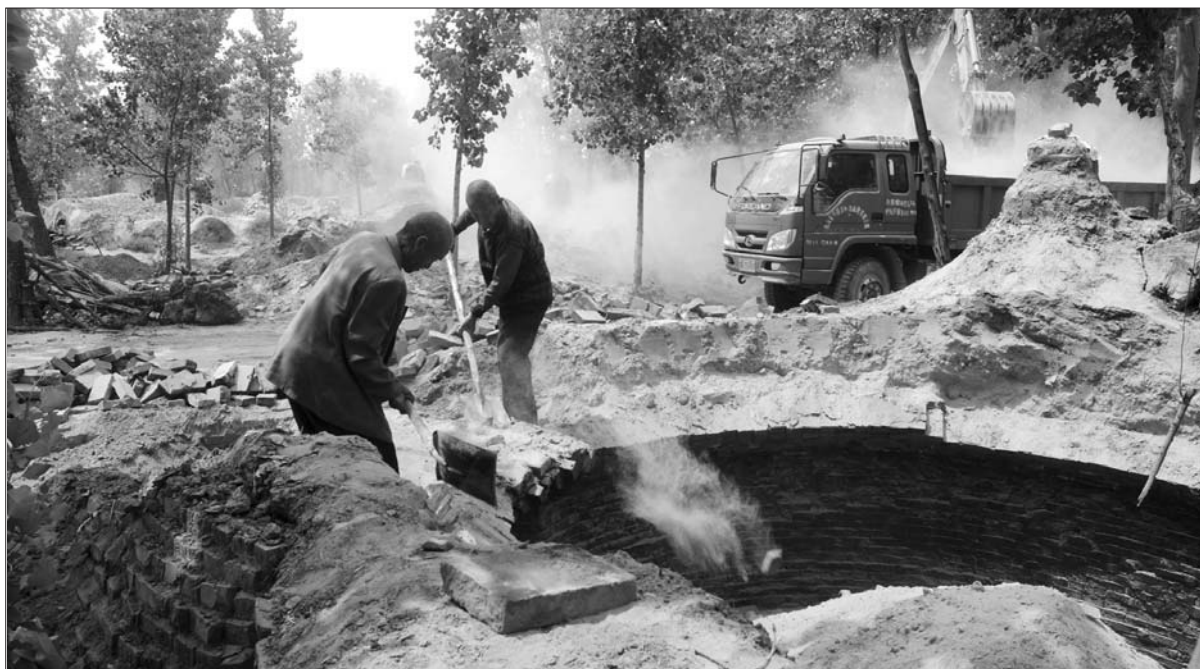
村民正在拆除烧炭窑。 本报记者 马志勇 摄
