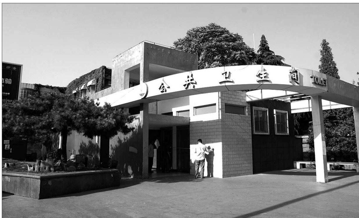
即将改造提升的公共卫生间。
