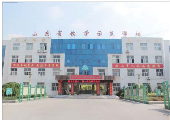
气派的教学楼
