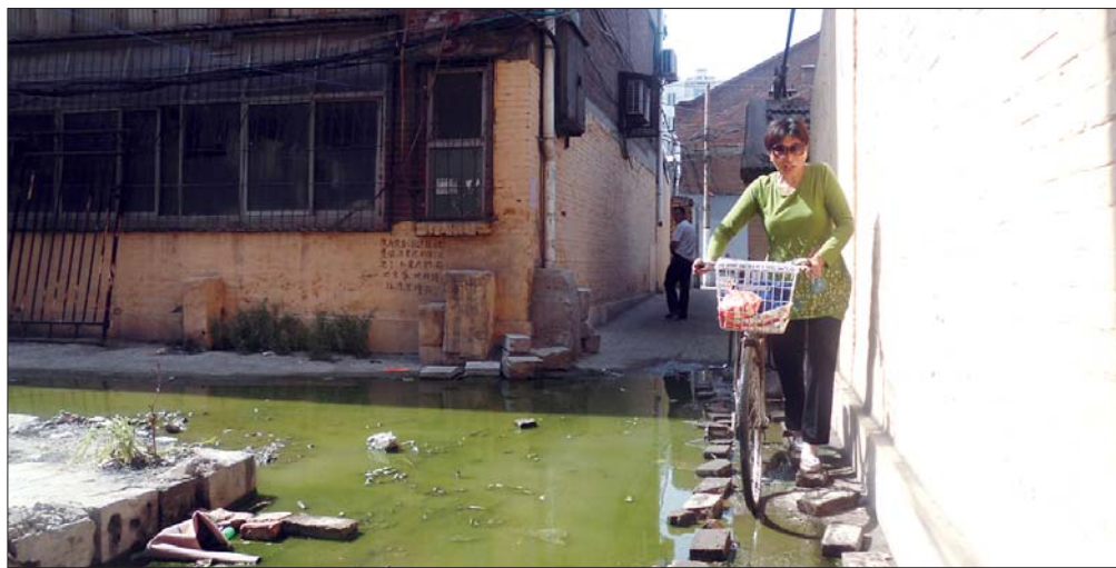
化粪池溢出的污水,给居民生活带来极大不便。本报见习记者 苏洪印 摄
